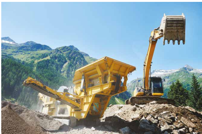
Bloccaggio di un volano di un frantoio tramite SIT-LOCK® 4.
